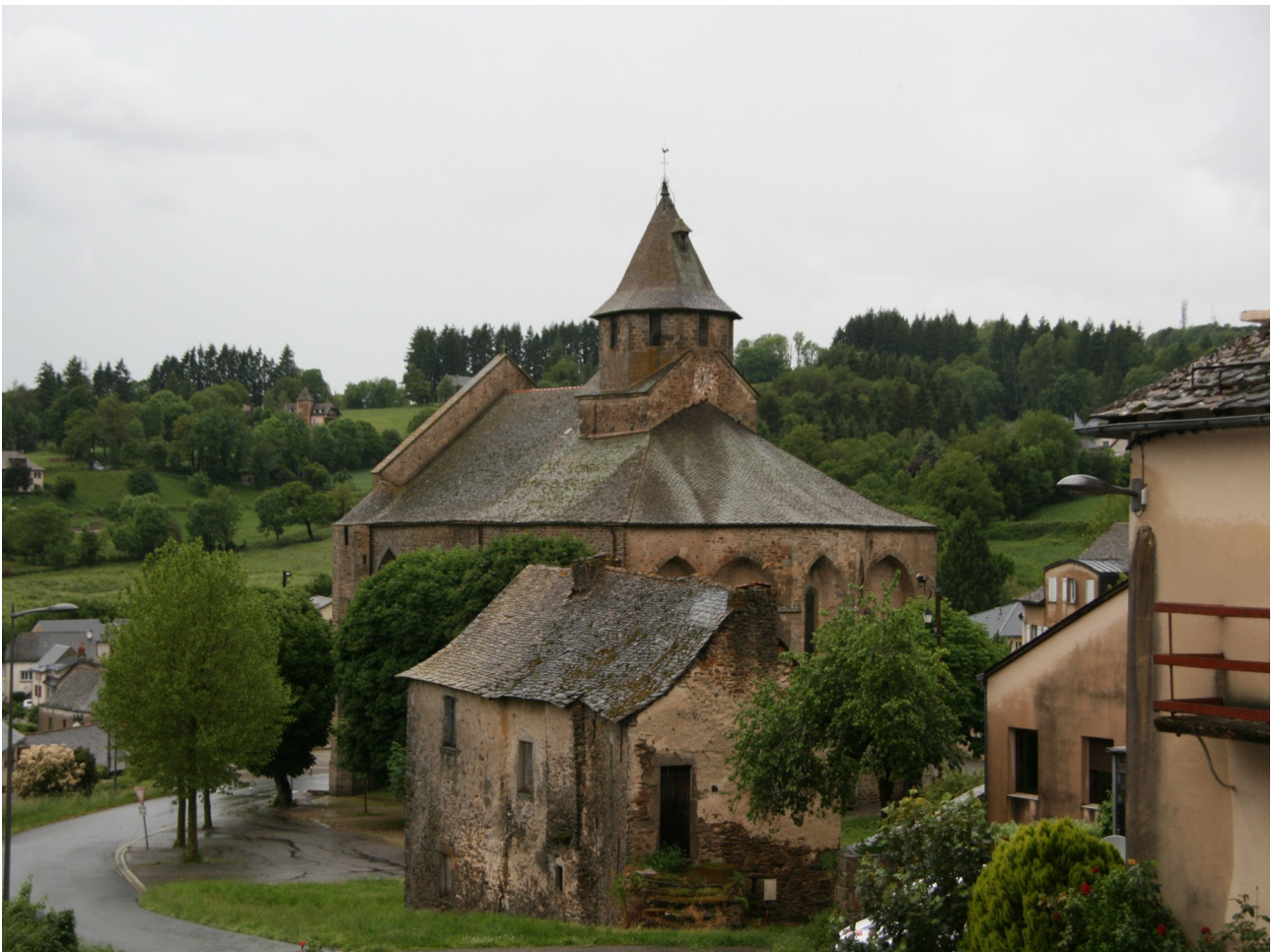
Figure 1: l'église Saint-Martial, en limite de l'ancien bourg d'origine médiévale.
